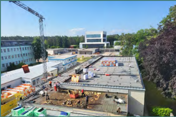
Abbildung 20: Sanierung der großen Dachfläche von Gebäude 241
