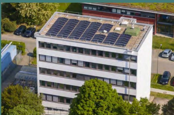
Abbildung 21: Impressionen unserer im Herbst 2024 installierten Photovoltaikanlagen
