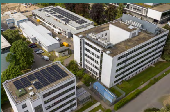
Abbildung 21: Photovoltaikanlagen FIZ Karlsruhe
