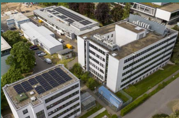
Abbildung 21: Photovoltaikanlagen FIZ Karlsruhe
