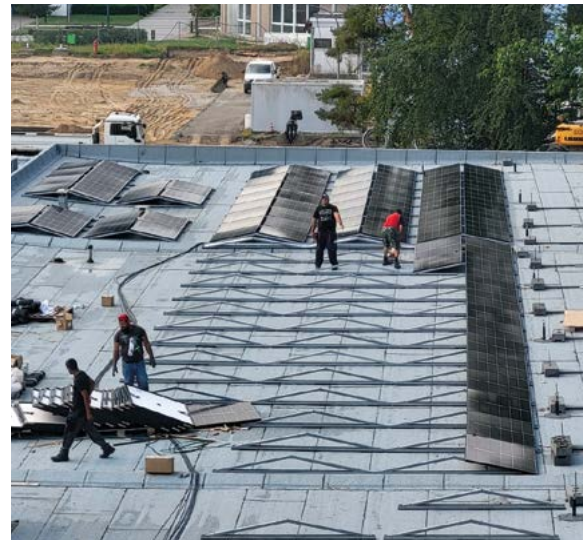
Installationsarbeiten PV-Anlage auf dem Dach
