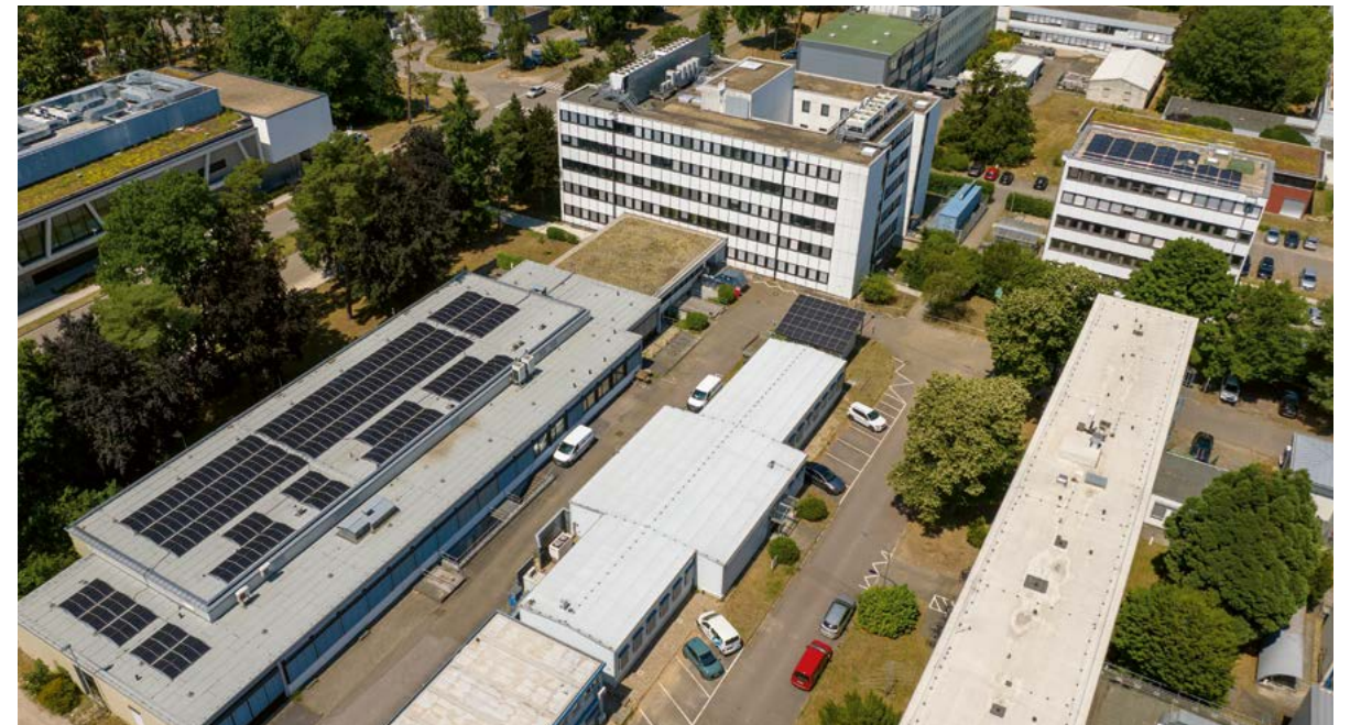
Drohnenflug-Aufnahme der PV-Anlage
